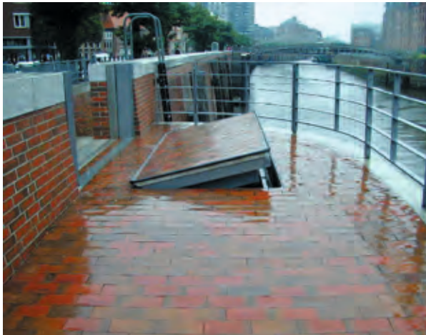
Integrierte Hochwasserschutzklappe
