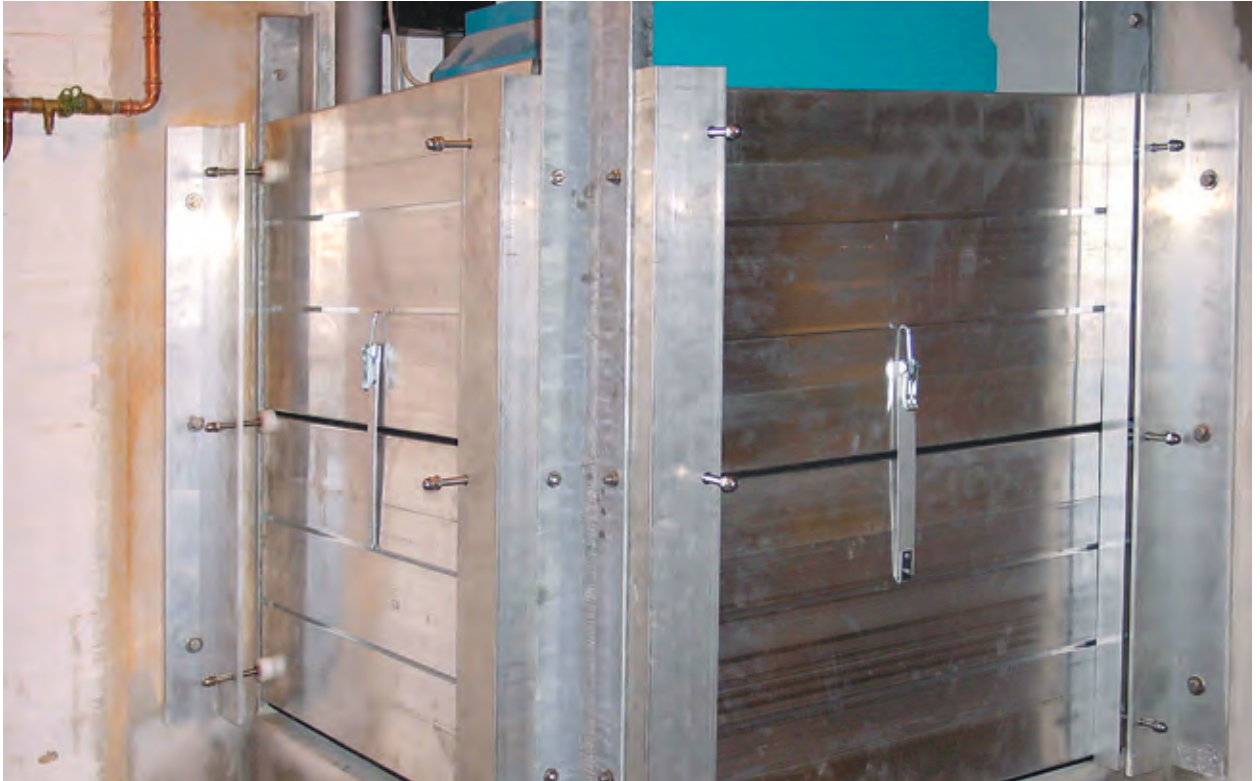
Sicherung eines Heizbrenners
