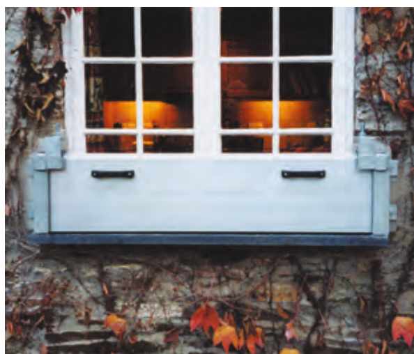
Hochwasserschutz an Fensteröffnungen
