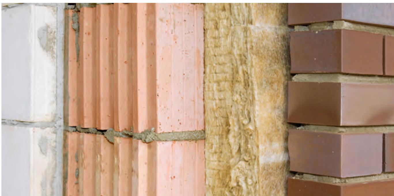
Mehrschalige Außenwandkonstruktion
