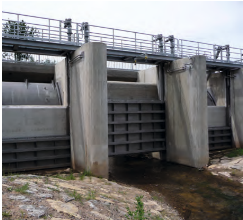
Verschlussbauwerk eines Hochwasserrückhaltebeckens
