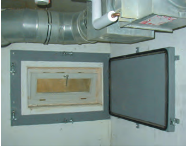
Druckdichtes Fenster
